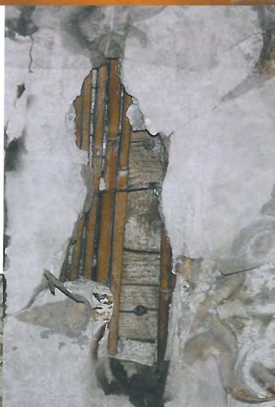
Hol Eo2 Biblioteca, tavan, decorat cu texte și rozete și vrejuri, lacună profundă pe fisură transversală, care evidențiază structura de trestie prinsă pe scânduri. Ansamblu și detalii.
