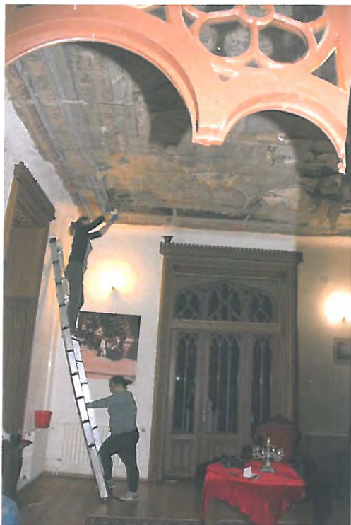
Aspecte din timpul realizării testelor și sondajelor.
