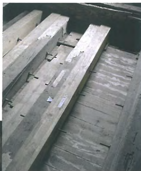
Structura tavanelor, vedere cu extradadosul grinzilor din pod, tavan de la Casa scării secundare, vedere cu scândurile bătute pe grinzi într-o lacună mare, foto din 2004, înainte de intervențiile la arhitectură din 2004-2005.
