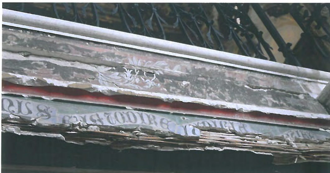
Casa scării EO1, est, parte frontală, decorată cu eșarfă cu text, pierderi ale preparației care evidențiază structura de trestie prinsă pe scânduri. Detalii cu preparația care acoperă trestia, strat subțire pe tavane.
