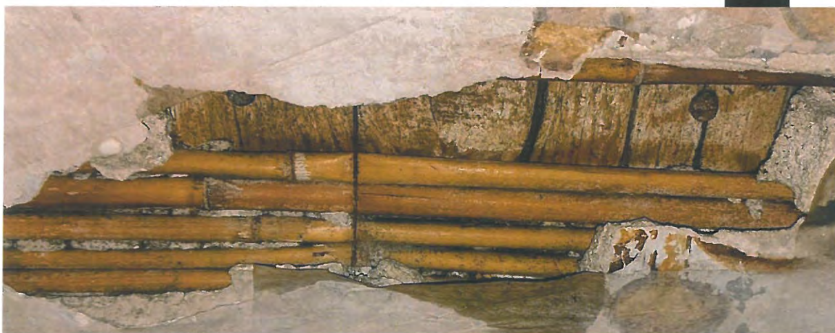
Casa scării EO1, est, parte frontală, decorată cu eșarfă cu text, pierderi ale preparației care evidențiază structura de trestie prinsă pe scânduri. Detalii cu preparația care acoperă trestia, strat subțire pe tavane.
