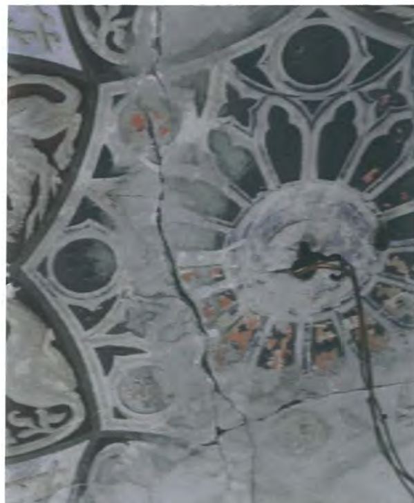
Detalii – porțiuni a stratului de culoare decolorată de infiltrații și transformare pigment roșu cinabru.
