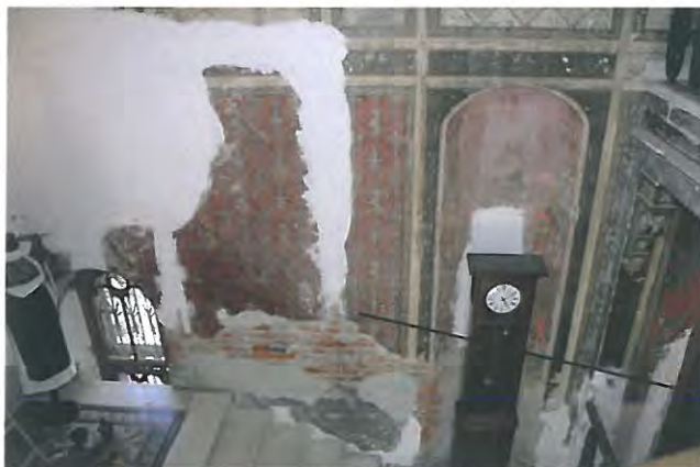
Casa scării principale, perete nordic, zidăria de cărămidă, stratul arriccio și stratul intonaco, cu aceeași compoziție – var și nisip, dar cu grosimi diferite.
