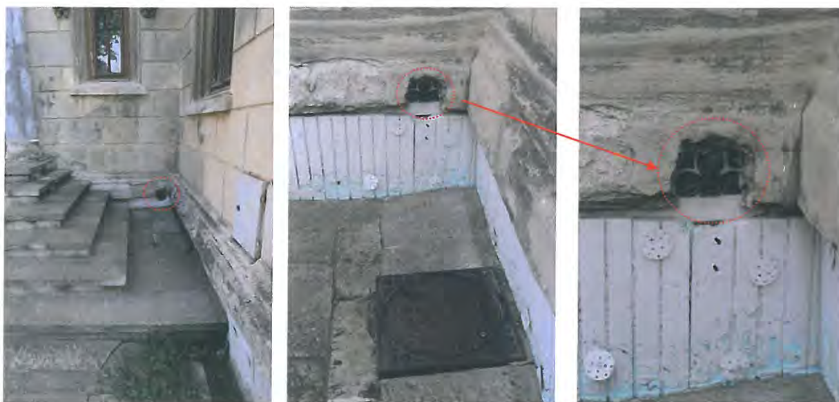
Gură de ventilare originală localizată la baza fațadei sudice.
