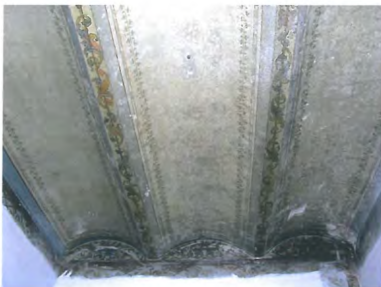
Structură bolți cilindrice - în spațiile aparținând vechiului conac, Baia originală pe nord - bolți de cărămidă pe profile metalice.
