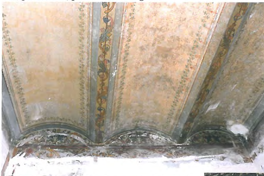
P11, parte nord, parter - Baia originală
