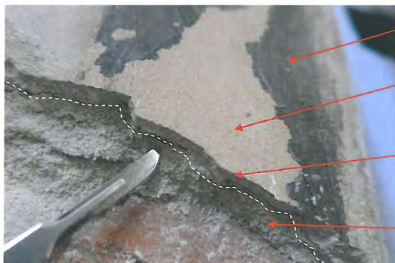
Casa scării principale, perete nordic, zidăria de cărămidă, stratul arriccio și stratul intonaco, cu aceeași compoziție – var și nisip, dar cu grosimi diferite.
