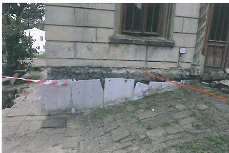
Imagini de ansamblu și detalii cu baza pereților castelului, polistiren extrudat și ciment aplicat în intervențiile de restaurare a arhitecturii din 2003-2005.
