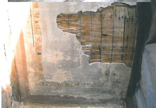
Structura tavanelor, vedere cu extradadosul grinzilor din pod, tavan de la Casa scării secundare, vedere cu scândurile bătute pe grinzi într-o lacună mare, foto din 2004, înainte de intervențiile la arhitectură din 2004-2005.
