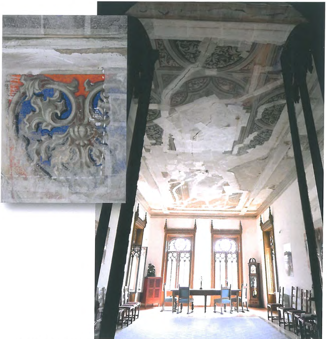
Salonul castelului (încăperea E04), care păstrează tavanul decorat cu pictură murală, pe care s-au făcut intervenții în 2003-2004 pentru asigurarea picturii și consolidarea structurii și preparăției grav desprinse. Detaliu cu un test de eliminare a facing-ului de pe pictură.
