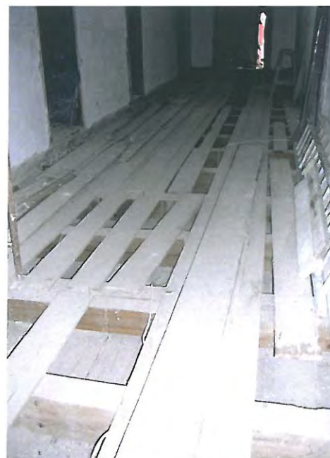
Structura tavanului de la holul P16 parter, vedere cu extradadosul - grinzile din holul de deasupra (biblioteca), și detaliu, foto din 2004, înainte de placarea cu marmură.
