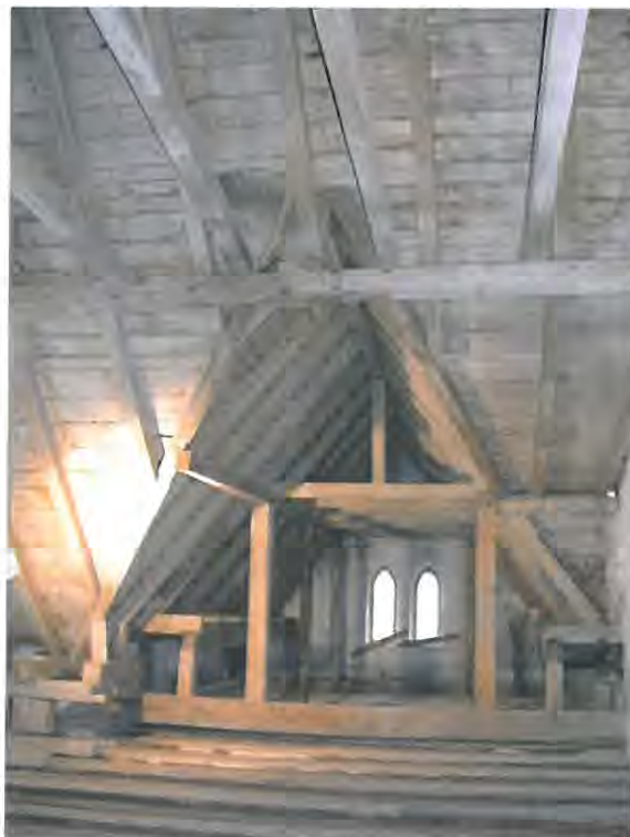
Structura podului, foto din 2004, înainte de mansardare.
