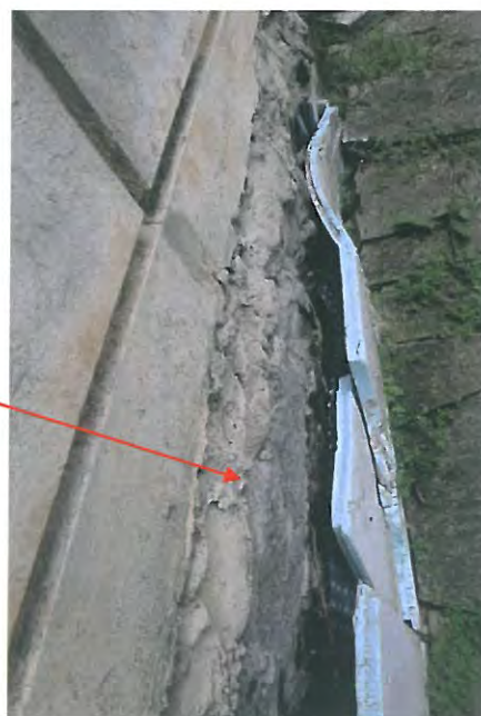
Imagini de ansamblu și detalii cu baza pereților castelului, polistiren extrudat și ciment aplicat în intervențiile de restaurare a arhitecturii din 2003-2005.
