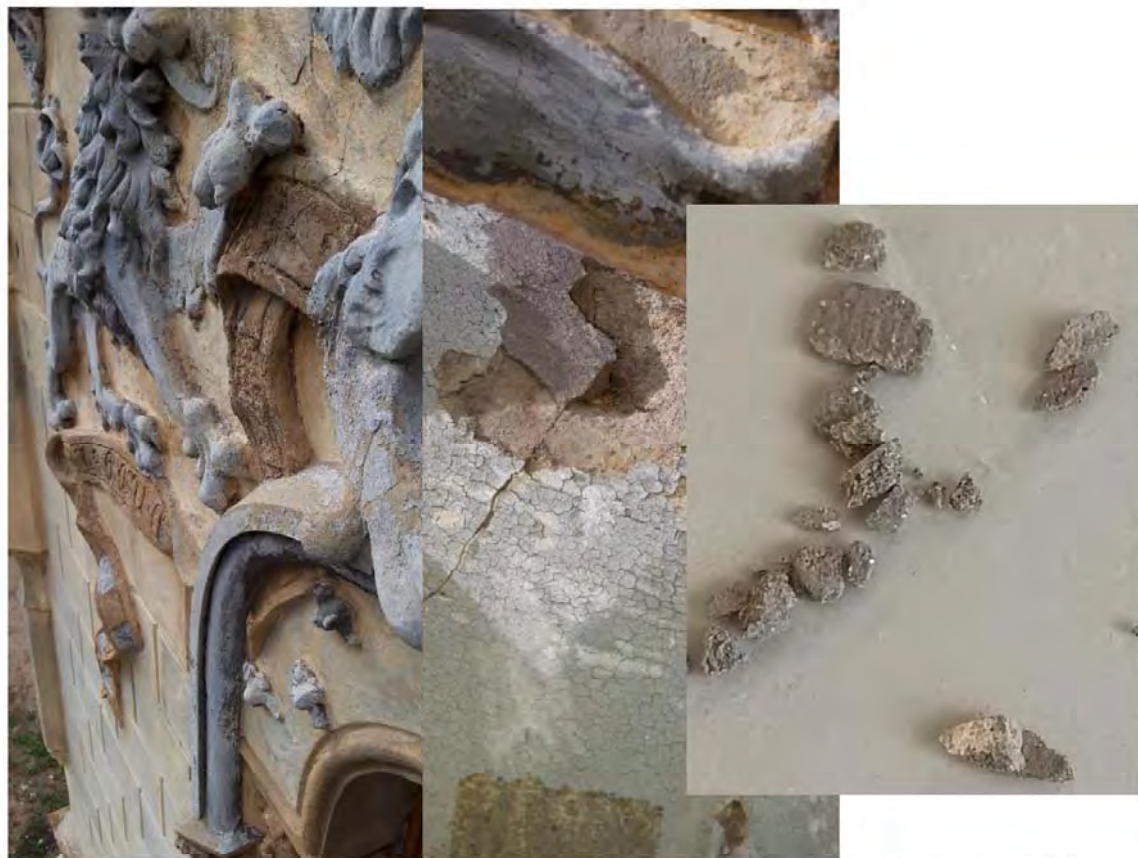
Proba P33. Fațada sud, partea sud-vestică, Stema monumentală a castelului cu patru lei susținând blazonul familiei Sturdza , probă din strat de reparație dură cu ciment existent pe aria din spatele leilor, acoperită cu culoare brun peste un strat anterior ocru (ambele probabil var lavabil din 2004-2005).
