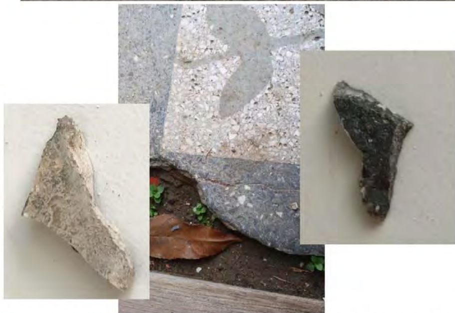
Proba P9. Fațada sud, partea sud-vestică, pavimentul cu textul „Salve” din fața intrării A în castel, probă cu porțiuni de tonalitate neagră + probă din stratul de preparație al mozaicului (de pe chenarul negru al mozaicului).
