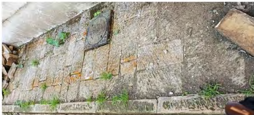
Foto.17 Vegetație ierboasă crescută printre blocurile de piatra și în cavitațiile acestora
