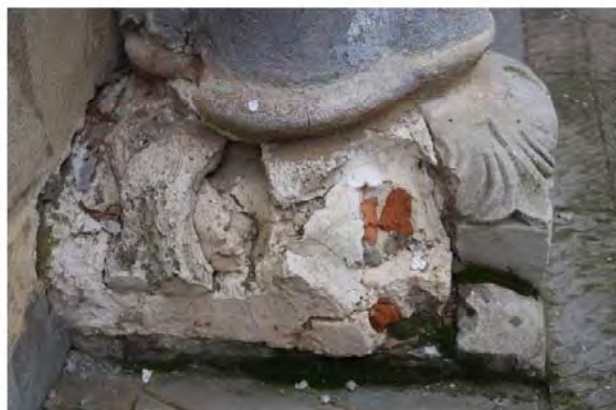
Fig.5 Proba P 5. Mortar de reparație de la baza coloanei din stânga a. micrografie OM 500X b. spectrul XRF;
