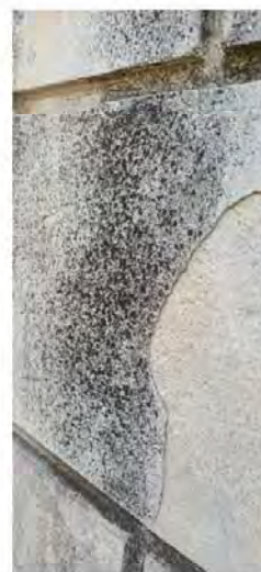
Foto 9 Halouri umiditate, crustă biodermă neagră ligheni genul Buellia, pulverulențe desprinderi tencuială perete etaj vest
