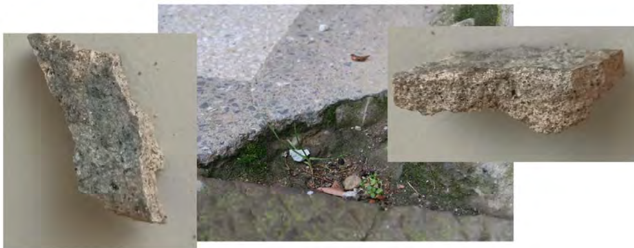
Proba P9a. Fațada sud, partea sud-vestică, pavimentul cu textul „Salve” din fața intrării A în castel, probă cu porțiuni de tonalitate gri + stratul de preparație al mozaicului.
