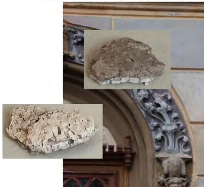
Proba P27b. Fațada sud, partea centrală, fronton fereastră, partea superioară, elemente profilate – vegetale, probă din stratul de culoare solzit ocru-brun (la suprafață) + strat de preparație subțire.
