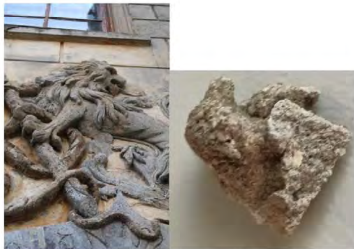
Proba P19a. Fațada vestică, intrare secundară, decorație heraldică profilată - Leu cu șarpe localizată deasupra intrării, probă din materialul suport prelevat de pe șarpe.
