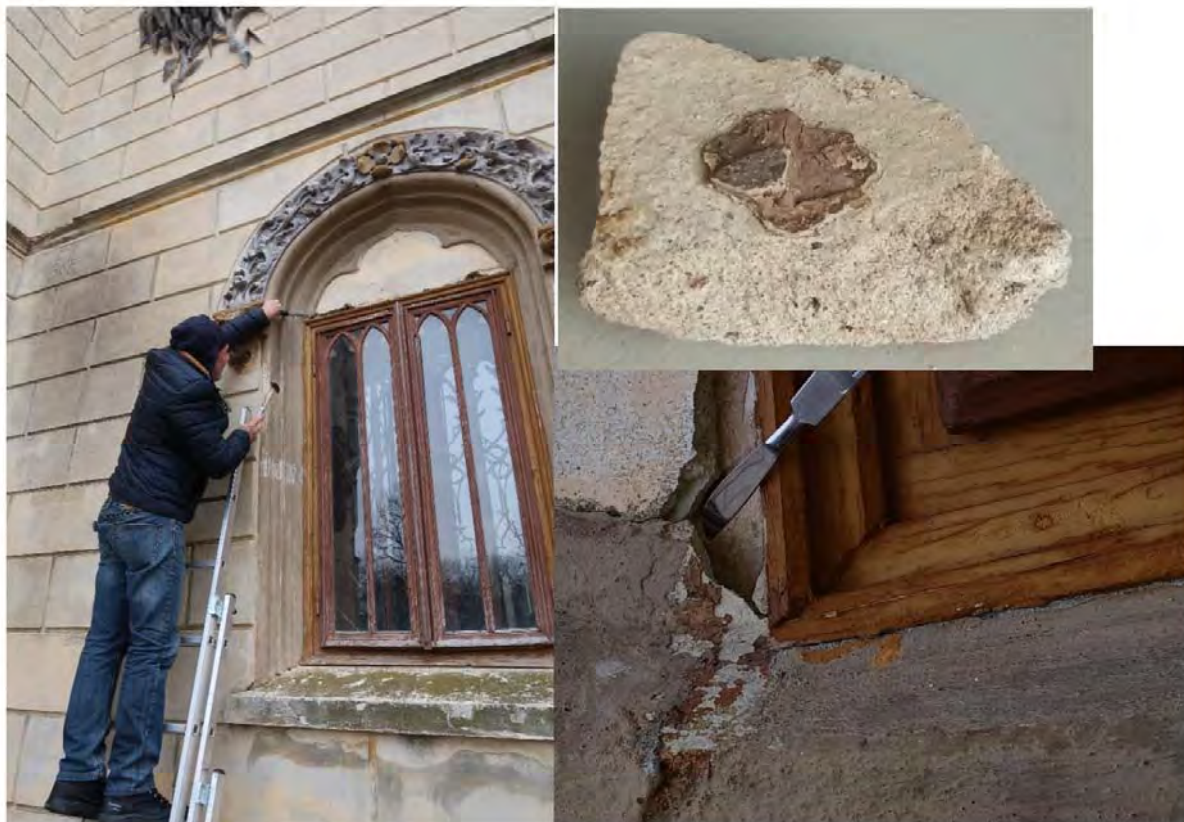
Proba 2 P2. Fațada sud, partea vestică, probă de preparare cu strat de culoare ocru-verde de pe profilul primei ferestre, de pe partea superioară.
