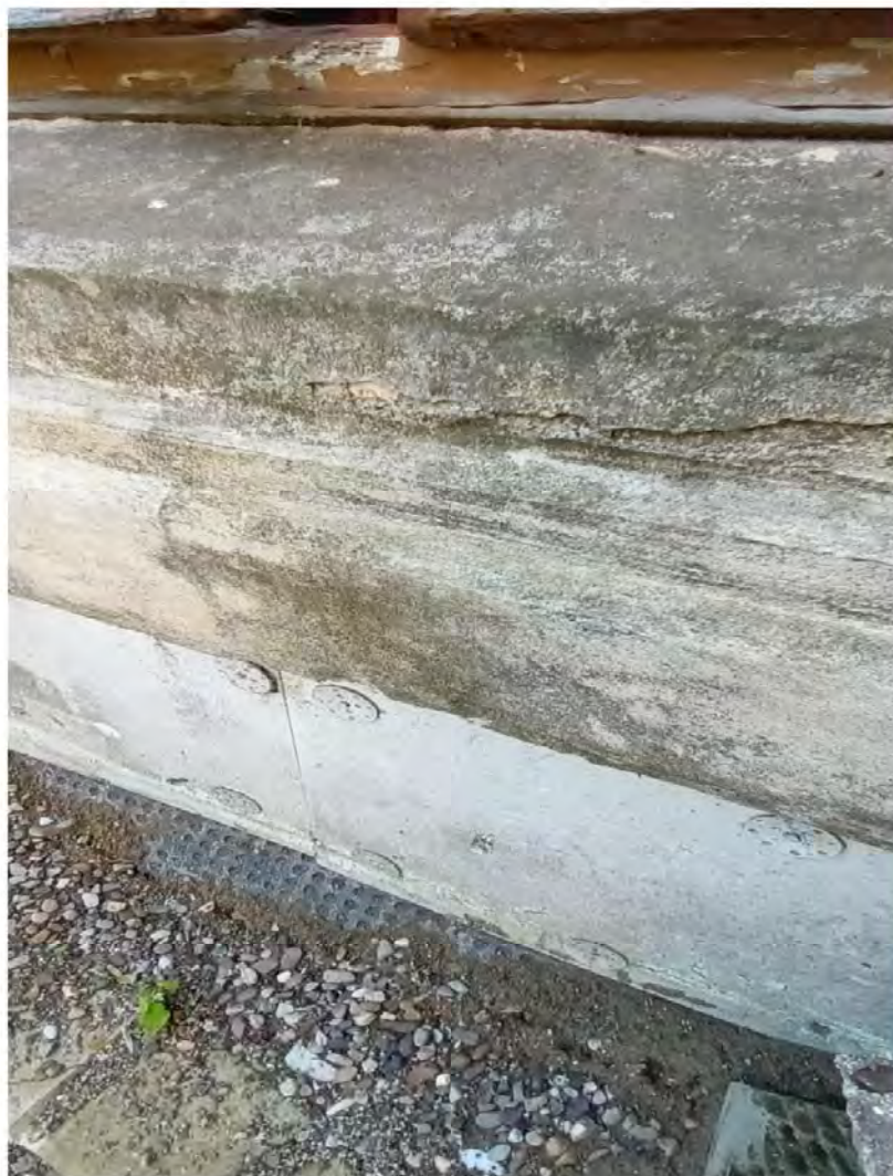
Foto10. Soclu nord acoperit cu polistiren, desprinderi tencuieli brâu decorativ, umiditate, biocrustă
