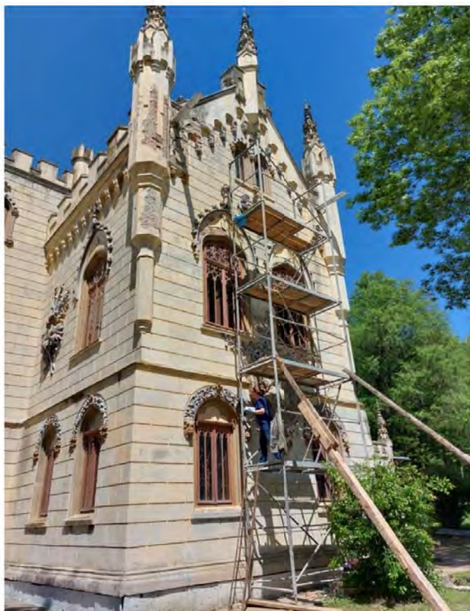
Castelul Sturdza - Miclăușeni, mai 2022, vedere de pe latura sudică, în timpul realizării cercetării stratigrafice a elementelor decorative exterioare.
