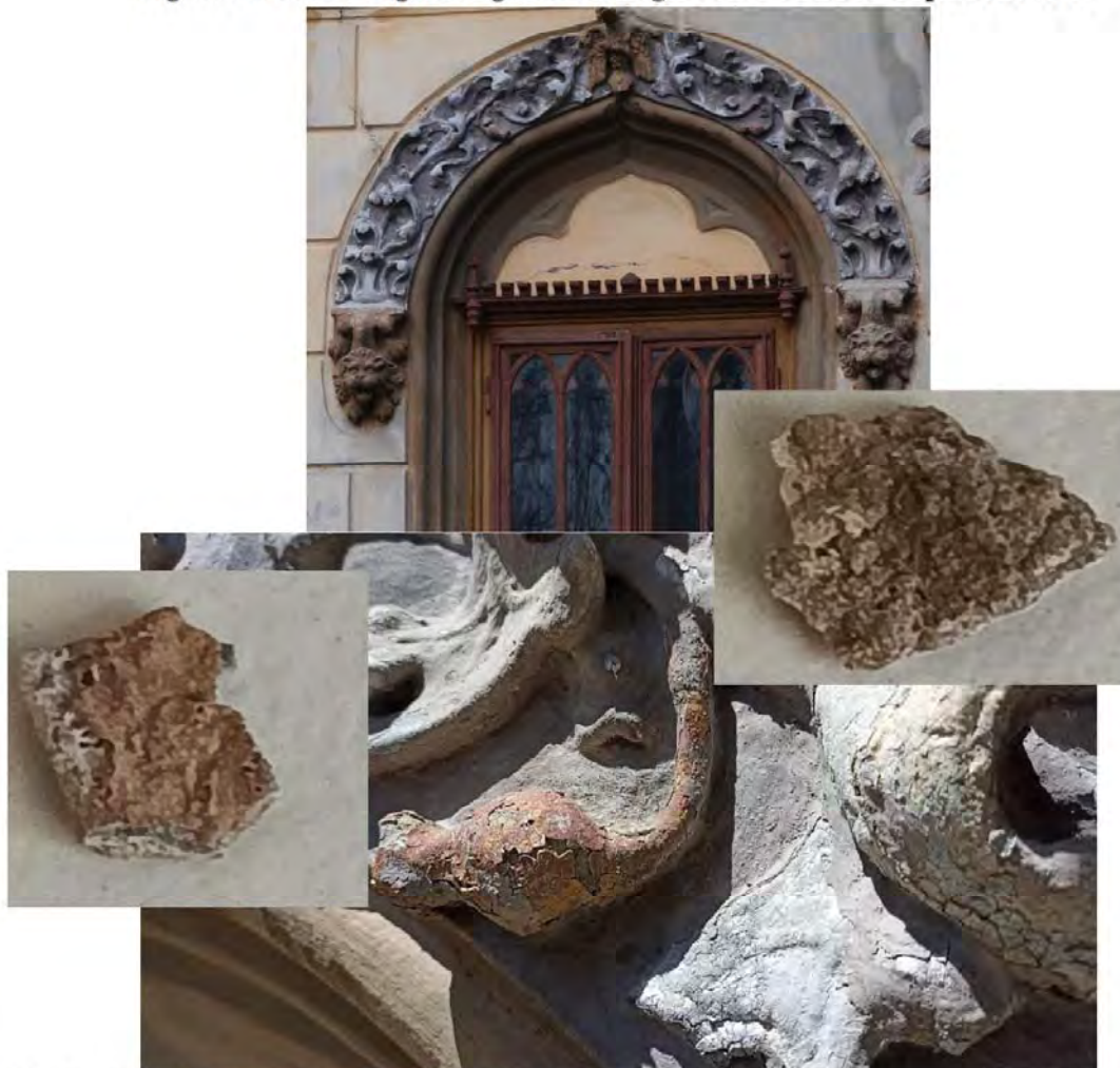
Proba P25. Fațada sud, partea centrală, fronton fereastră cu elemente profilate, partea superioară, element profilat – floare, probă din stratul de culoare roșu + strat de preparare subțire.
