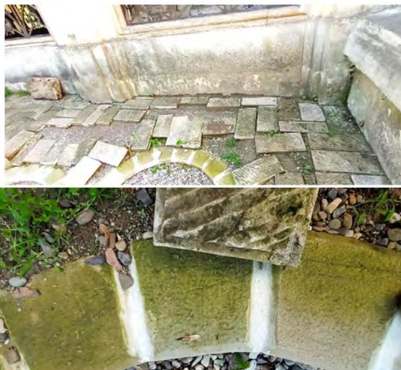
Foto 16 Pe zid și alee partea de nord predomină un biofilm format preponderent din alge verzi din genul Chlorococcum sp
