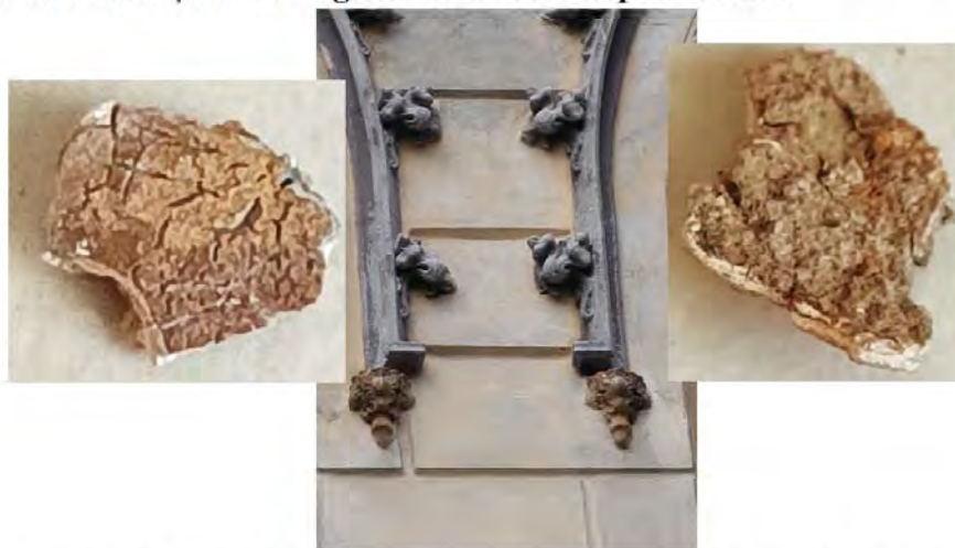
Proba P26 Fațada sud, partea centrală, fronton fereastră cu elemente profilate, partea superioară, elemente profilate – vegetale, probă din stratul de culoare solzit ocru -roșu + strat de preparație subțire.
