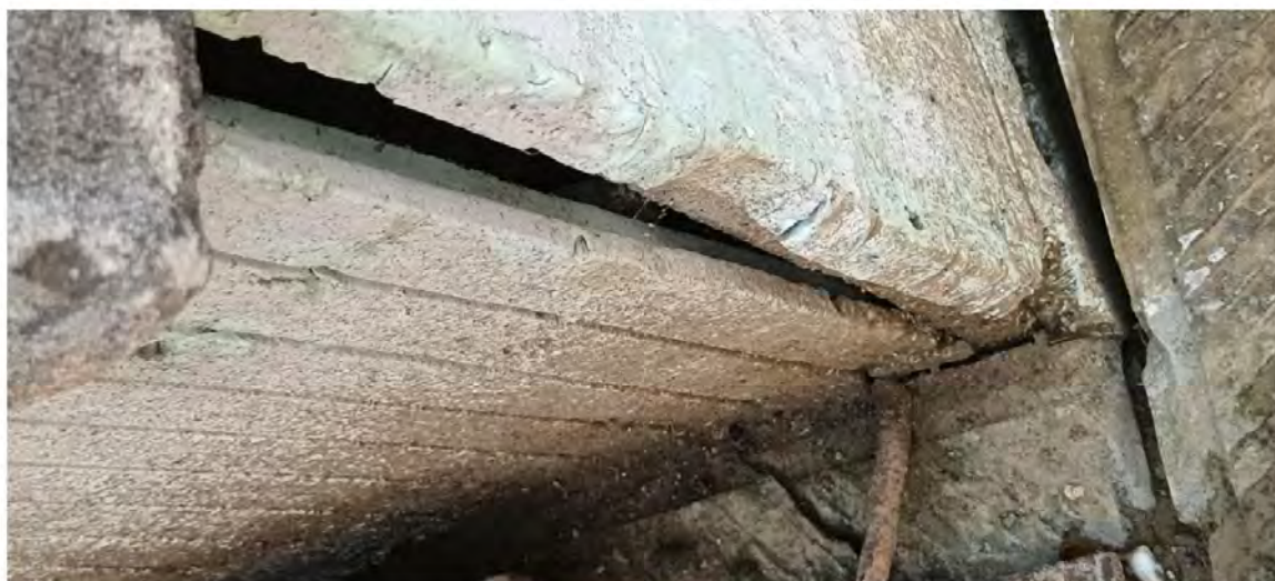
Foto 7 Soclu Vest acoperit cu polistiren
