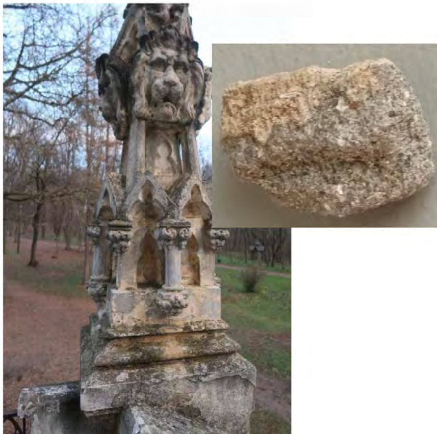
Proba P17. Terasa castelului, partea estică, Fleșă cu capete de lei , probă din materialul suport.
