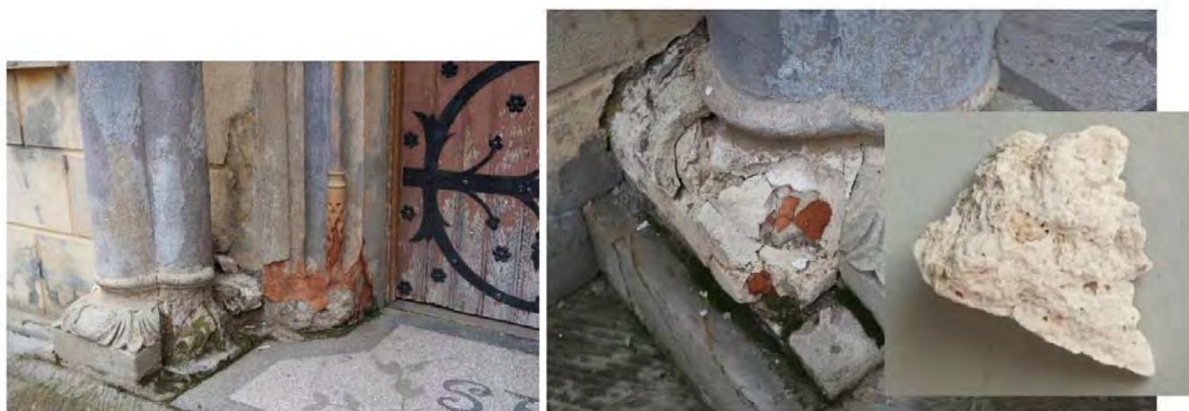
Proba P5. Fațada sud, partea sud-vestică, ancadramentul cu coloane de la intrarea A în castel, probă din mortar de reparație de la baza coloanei din stânga.
