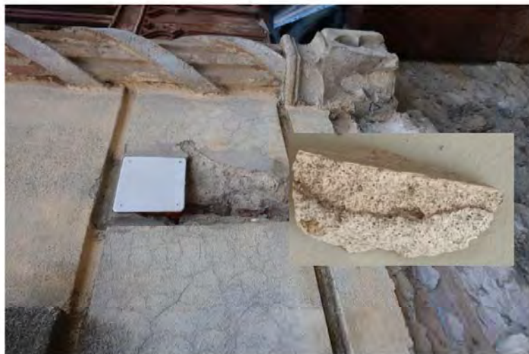
Proba P16. Fațada estică, partea sud-estică, profilul soclului castelului, probă din materialul suport cu strat de culoare ocru din 1900.
