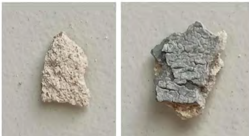
Proba P8. Fațada sud, partea sud-vestică, ancadramentul cu coloane de la intrarea A în castel, probă din preparare + strat de culoare al fusului coloanei din stânga.
